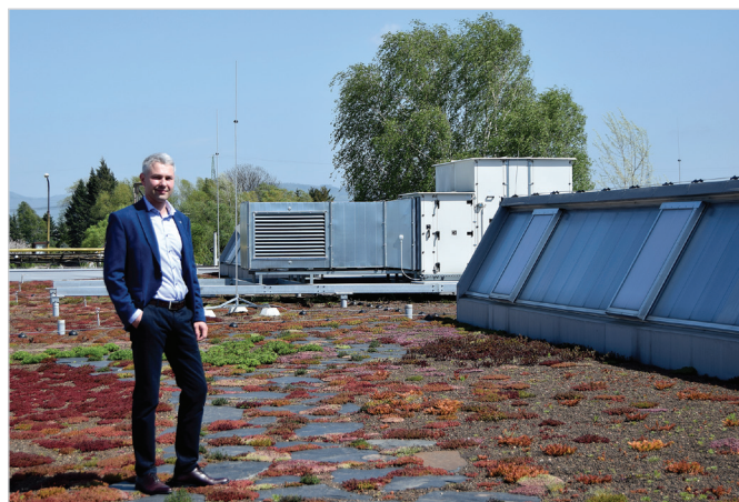
Pavel Straka na své oblíbené zelené střeše pokrývající výrobní halu. Vzadu je vidět jednotka rekuperace vzduchu.
