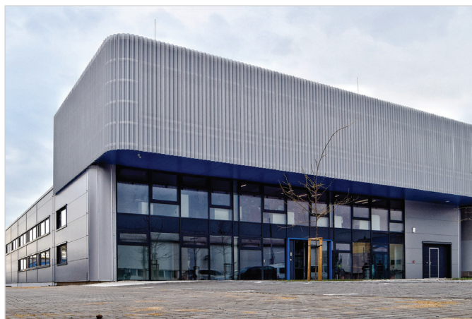
Nová administrativní budova propojená s výrobní halou
